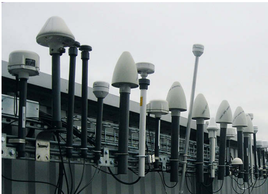
Fot. 1. Widok dachu zakładu produkcyjnego zapelnionego antenami GPS
